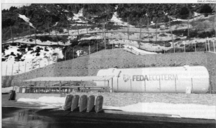
► El centre de cogeneració de FEDA a Canillo.
